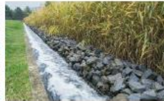
Der leitungsbedienbare mit Regenklärboden in Adamböf entlastet den Mikrotank, indem er die geringste Regenwasserentlastung in das Gewässer einleitet.
