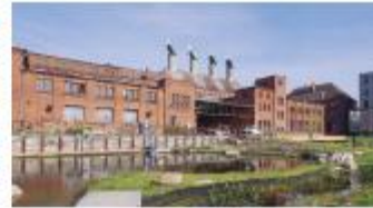
Durch Dachbegrünung und künstliche Wasserflächen zu dem Gelände der HUG Mahlsdorf in Schöneberg trägt nicht nur die Retention von Regenwasser – das Wasser kann auch als Betriebswasser verwendet werden.
